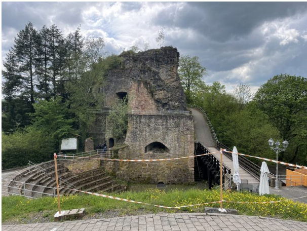
Burg Falkenstein von der Straße aus betrachtet (Franziska Rösner, 2021)
