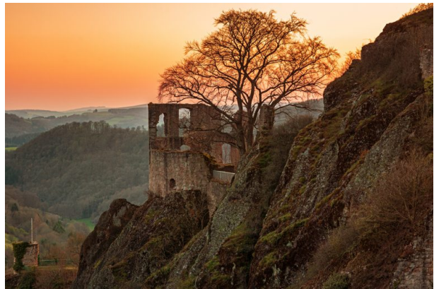
Blick auf die Ruinenwand der Burg Falkenstein, die von Fensteröffnungen durchbrochen ist (Harald Kröher, 2020)
