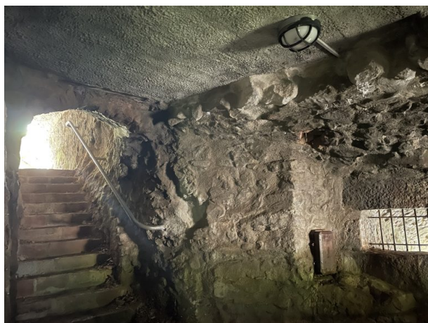
Gewölbekeller der Burg Falkenstein (Franziska Rösner, 2021)
