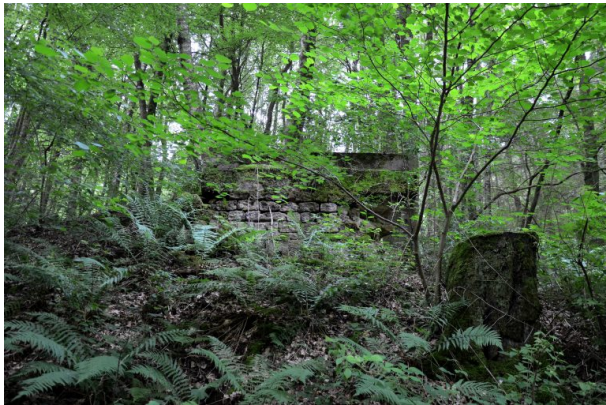
Reste einer Brücke der Wasgenwaldbahn (Dr. Hans-Günther Clev , 2021)
