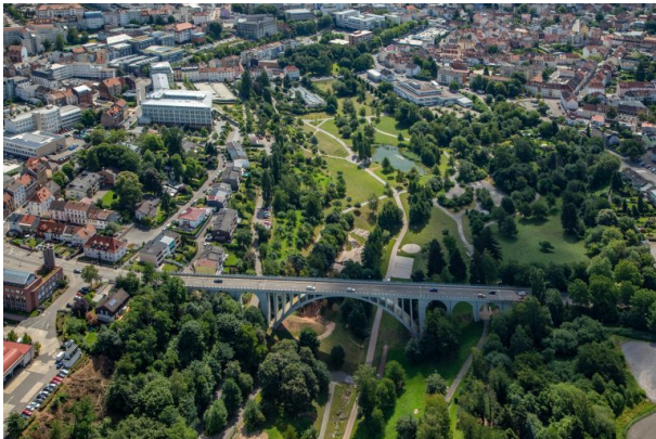
Streckbrücke über dem Strecktalpark in Pirmasens (Harald Kröher, 2018)
