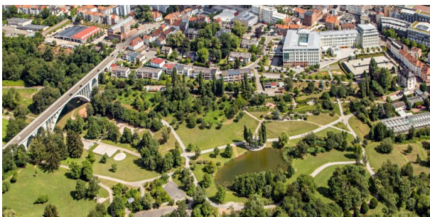
Luftaufnahme von der Streckbrücke und dem Strecktalpark. Im Hintergrund die ehemalige Schuhfabrik Rheinberger (Harald Kröher, 2018)
