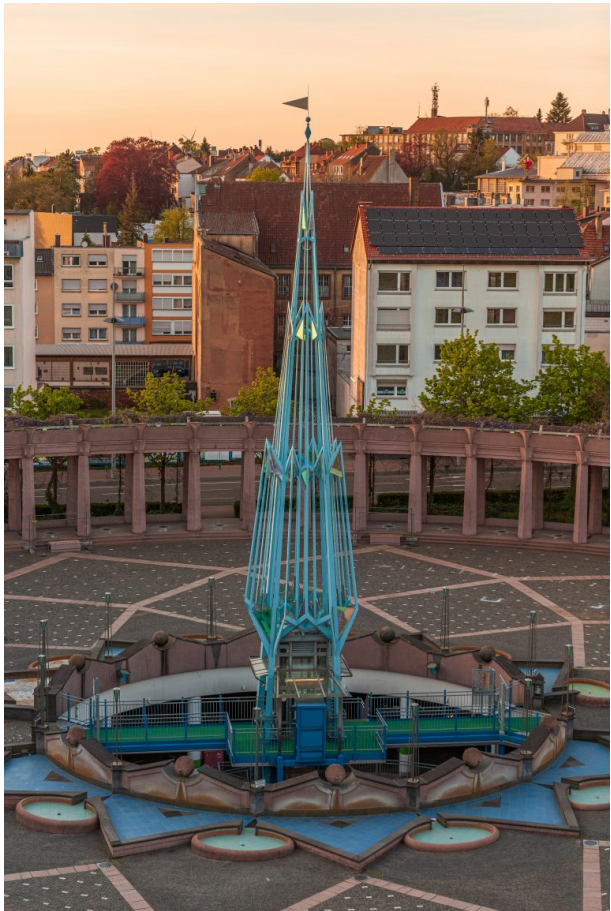
Brunnenanlage über der Tiefgarage auf dem Exerzierplatz (Harald Kröher, 2020)
