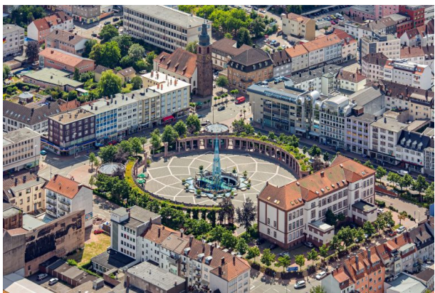
Luftaufnahme des Exerzierplatzes in Pirmasens (Harald Kröher, 2018)
