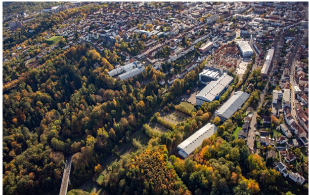
Blick über den Neufferpark auf das Gebäude Neuffer am Park (Harald Kröher, 2019)
