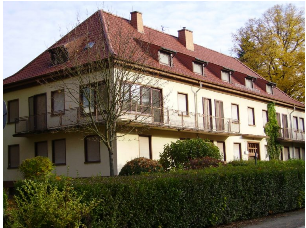
Wohngebäude der ehemaligen Fliegerstraße (Ralf Vester, 2008)
