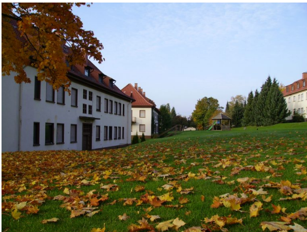
Ehemalige Gebäude der Fliegersiedlung im Jahr 2008 vor dem Abriss (Ralf Vester, 2008)
