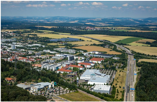
Luftaufnahme über den PRE-Park in Kaiserslautern (Harald Kröher, 2018)
