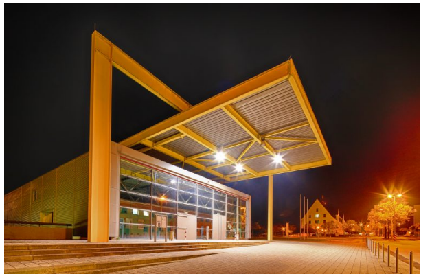
Heutiger Audimax der Hochschule Zweibrücken auf dem ehemaligen Kasernengelände (Bernd Wagner, 2018)
