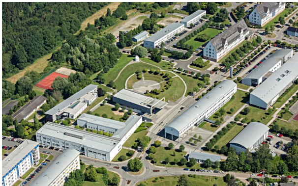
Luftaufnahme über die ehemalige Kreuzbergkaserne - heute Hochschule Zweibrücken (im Hintergrund zwei der erhaltenen Kasernengebäude) (Harald Kröher, 2018)
