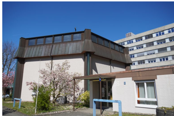
Krankenhaus-Kapelle in Landstuhl (Dana Taylor, 2022)
