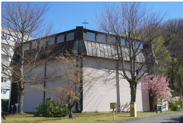
Krankenhaus-Kapelle in Landstuhl (Dana Taylor, 2022)
