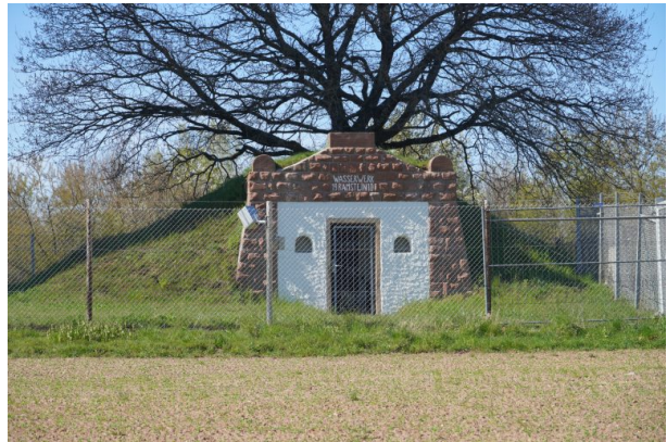
Ehemaliger Wasserspeicher in Ramstein neben dem heutigen Wasserturm (Dana Taylor, 2022)
