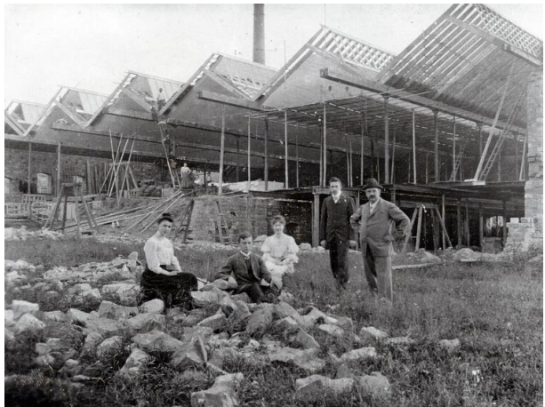
Die Familie Süßdorf um 1900 vor dem im Bau befindlichen Buntweberei
