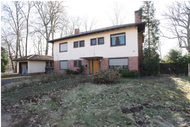
Die ehemalige Generalvilla in der Fliegerstraße in Kaiserslautern (o.A., 2011)
