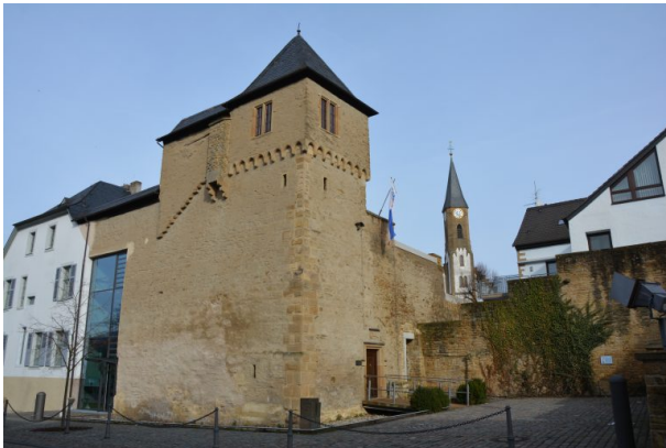
Blick auf den Turm aus südlicher Richtung (Sonja Kasprick, 2019)
