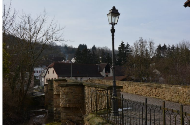
Oberlaufseite der Brücke. Hier sieht man die spitzen Wellenbrecher und die halbrunden Nischen darüber (Sonja Kasprick, 2019)
