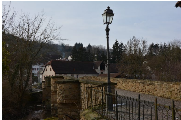
Oberlaufseite der Brücke. Hier sieht man die spitzen Wellenbrecher und die halbrunden Nischen darüber (Sonja Kasprick, 2019)
