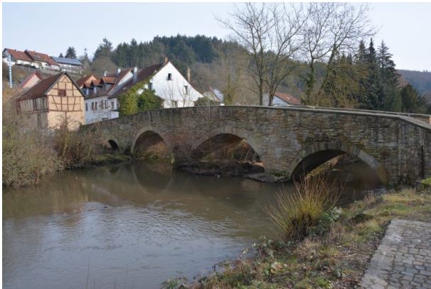
Blick auf die Brücke von westlicher Richtung (Sonja Kasprick, 2019)
