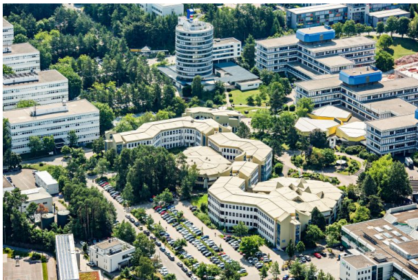
Campus der Technischen Universität Kaiserslautern, Rechenzentrum und Zentralbibliothek im Zentrum. Im Hintergrund das runde Verwaltungsgebäude. (Harald Kröher, 2018)
