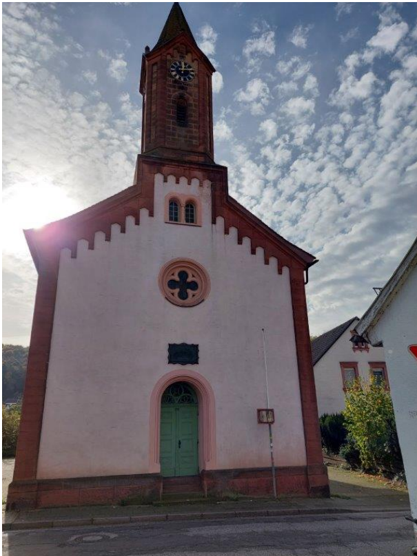
Ansicht auf das historische Gebäude (Motorradmuseum Otterbach)
