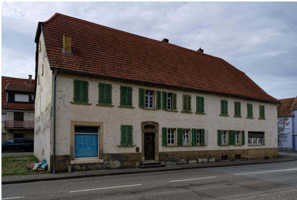
Putzbau mit grünen Fensterläden (Markus Eberl, 2024)
