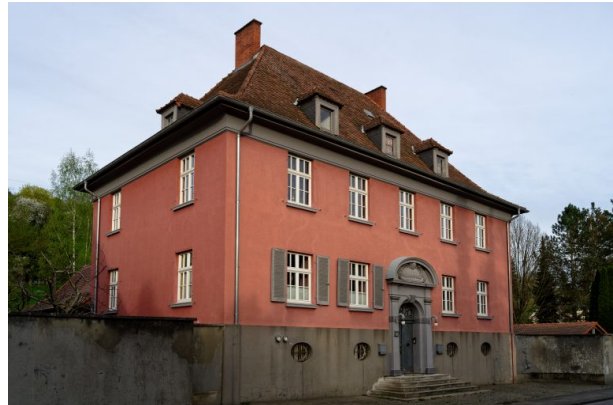
Ehemaliges Verwaltungsgebäude der Basalt-AG (Markus Eberl, 2024)
