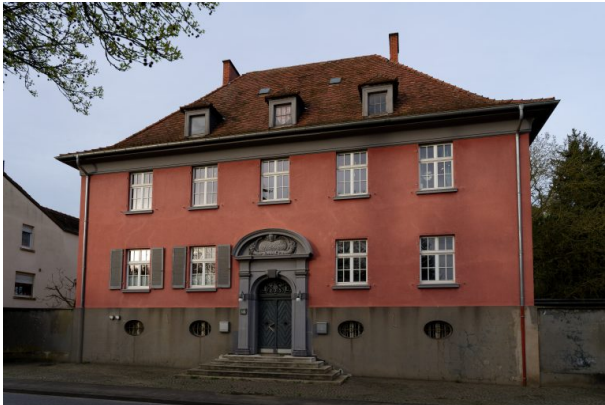
Ehemaliges Verwaltungsgebäude der Basalt-AG (Markus Eberl, 2024)
