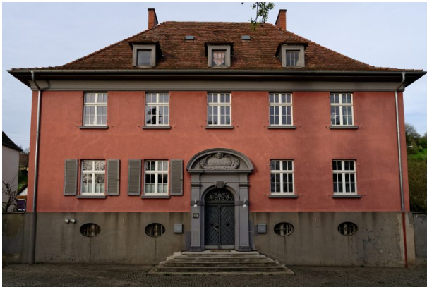
Ehemaliges Verwaltungsgebäude der Basalt-AG (Markus Eberl, 2024)
