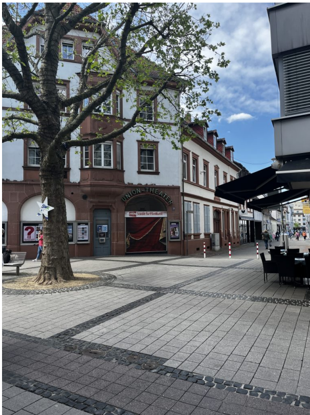
Erweiterter Blick auf das Gebäude (Philipp Markgraf, 2023)
