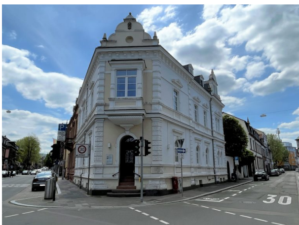
Nordwest-Ansicht des Gebäudes (Philipp Markgraf, 2023)
