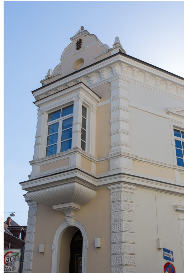
Nahaufnahme des Kastenerkers über dem Eingang. Auf dem Dach der Schweifgiebel. (Matthias Quinten, o.J.)
