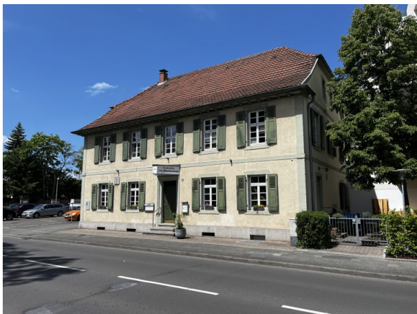
Blick auf das Gebäude aus nordöstlicher Richtung (Philipp Markgraf, 2023)
