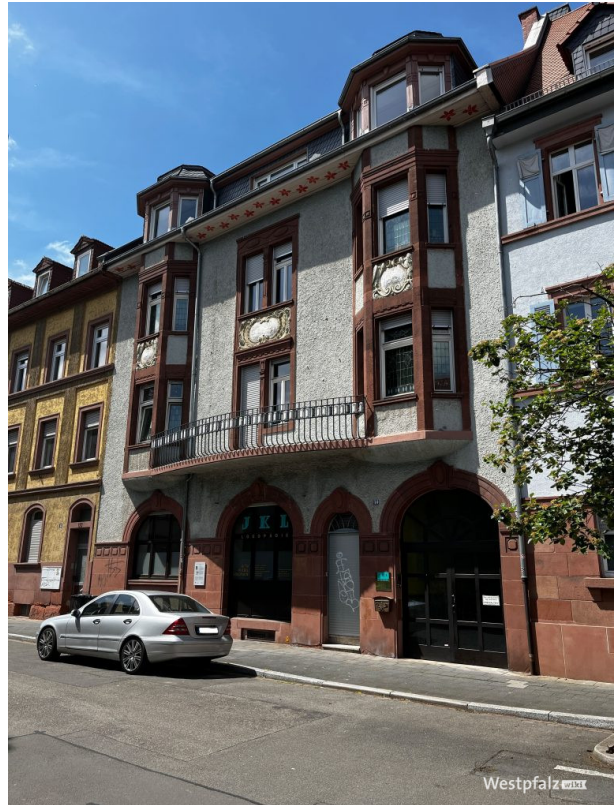
Blick auf das Gebäude aus nördlicher Richtung (Philipp Markgraf, 2023)
