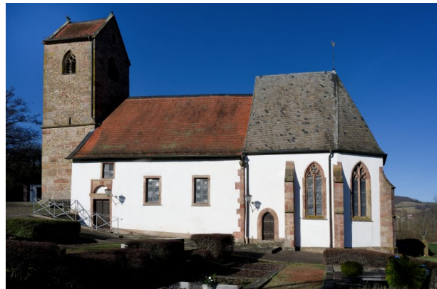
Blick auf die drei Gebäudeteile der Kirche (Markus Eberl, 2024)
