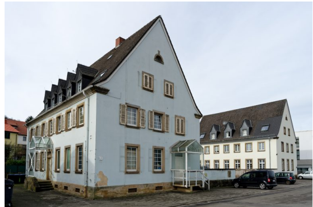
Gebäude Nummer 10. Das südliche der drei Gebäude. (Markus Eberl, 2024)
