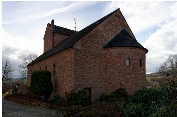
Blick auf die Kirche aus nordöstlicher Richtung (Markus Eberl, 2024)
