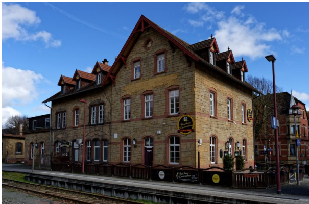
Empfangsgebäude vom gegenüberliegenden Gleis (Markus Eberl, 2024)
