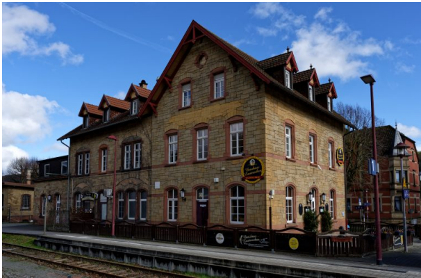
Empfangsgebäude vom gegenüberliegenden Gleis (Markus Eberl, 2024)
