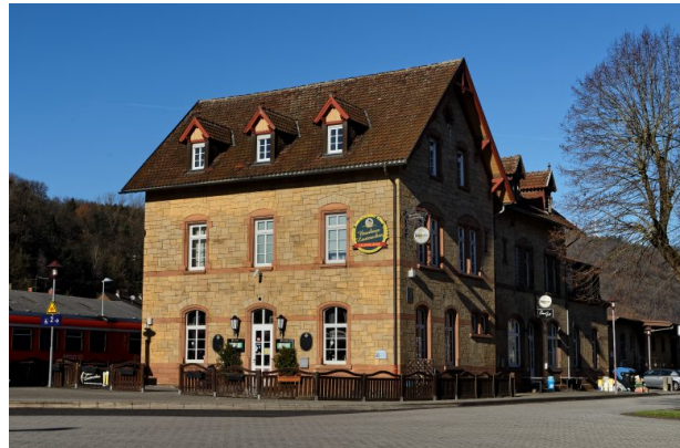
Hauptgebäude des Bahnhofs aus südlicher Richtung (Markus Eberl, 2024)
