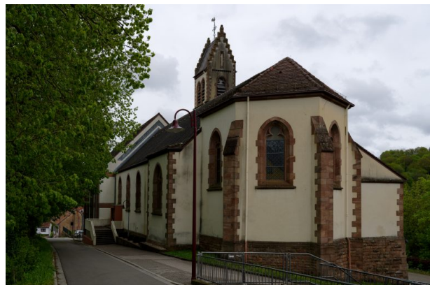
Eingang der Kirche an der Von-der-Leyen-Straße (Markus Eberl, 2024)
