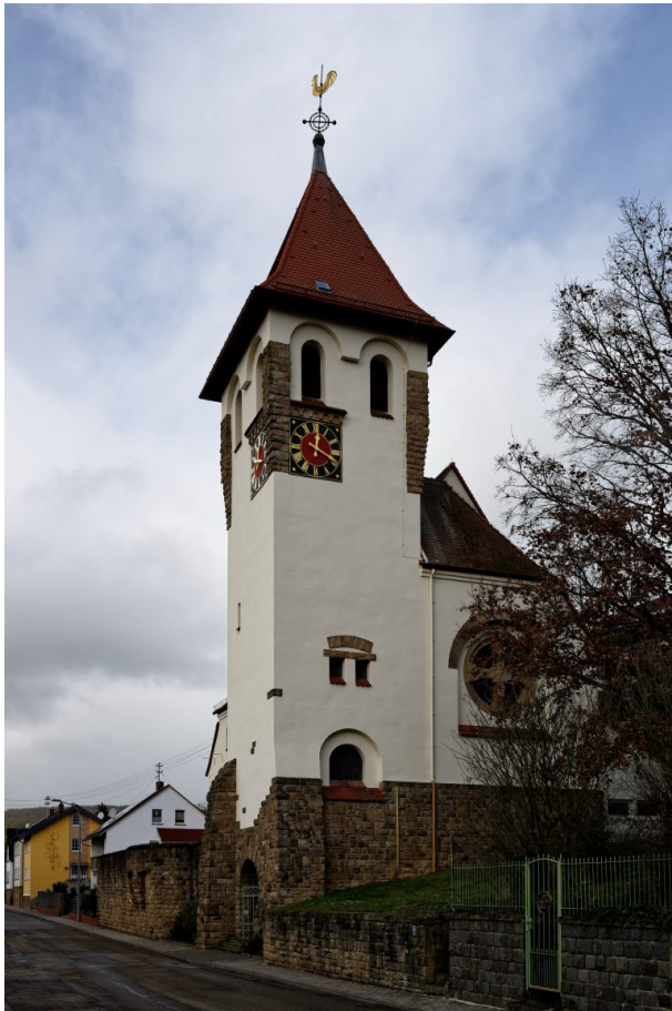
In der Fassade ist ein Mix aus Stein- sowie Putzelementen zu sehen (Markus Eberl, 2024)
