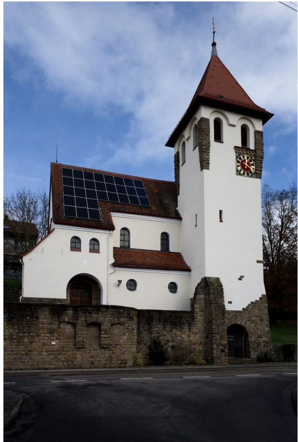
Gut zu erkennen ist der hohe Sockel. Auf dem Dach der Kirche befinden sich photovoltaik Anlagen (Markus Eberl, 2024)
