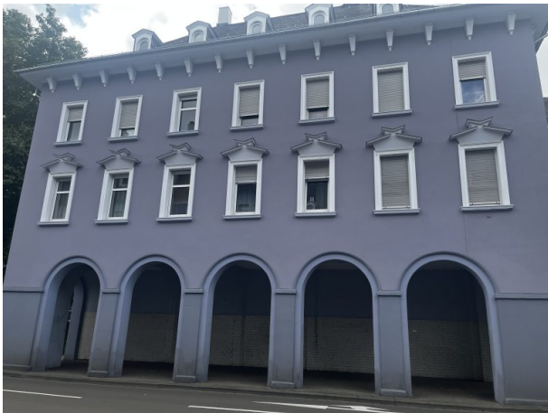
Wohngebäude auf der anderen Straßenseite der Anlage (Philipp Markgraf, 2024)
