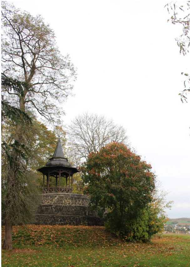
Schneckenturm beim Schillerhain in Kirchheimbolanden (Arne Schwöbel, 2017)
