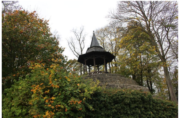
Schneckenturm beim Schillerhain in Kirchheimbolanden (Arne Schwöbel, 2017)
