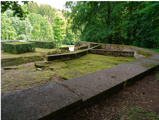
Blick über die Mauerreste der Ehrwoogburg in Zweibrücken in Richtung Süden. (Matthias Dreyer, 2018)
