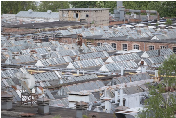
Blick auf die Dächer des alten Pfaff-Areals. (Benjamin Hörle, 2016)
