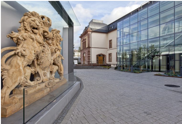
Einfahrt zum Haupteingang des Forum Alte Post in Pirmasens aus Südwesten. (Harald Kröher, 2014)
