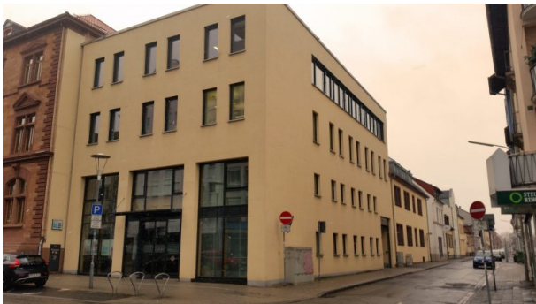
Moderner Anbau des Finanzamts in Kaiserslautern (Sonja Kasprick, 2019)
