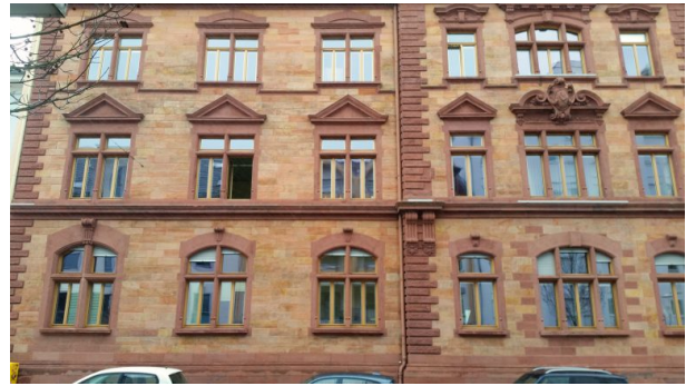
Historische Fassade aus Sandstein des Finanzamts in Kaiserslautern (Sonja Kasprick, 2019)
