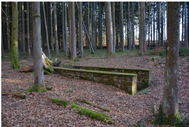
Der nördliche Zugang des Brunnenstollens in Trippstadt ist umgeben von Wald (Sonja Kasprick, 2019)
