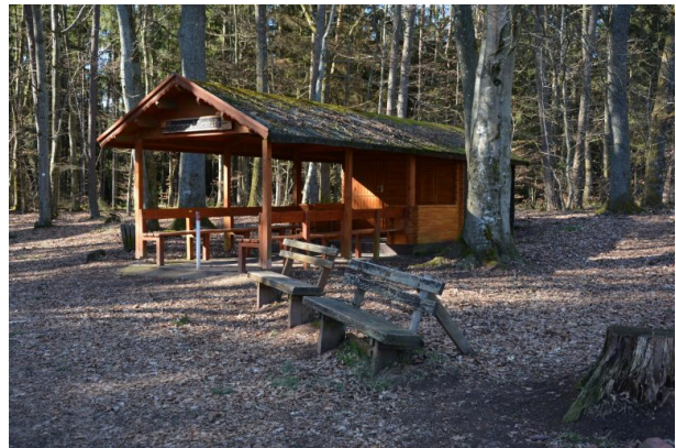
Brunnenstollenhütte am Waldrand bei Trippstadt (Sonja Kasprick, 2019)
