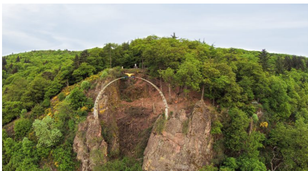
Luftaufnahme des Adlerbogens auf dem Dannenfels. (Anna Wojtas, 2015)
