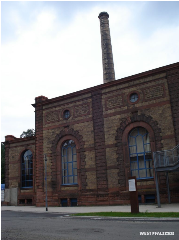
Kulturzentrum Kammgarn in Kaiserslautern. Im Hintergrund ragt der Schornstein der ehemaligen Spinnerei in die Höhe. (Arne Schwöbel, 2010)
