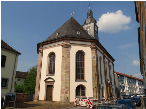
Ost-Front der Karlskirche in Zweibrücken (Matthias Dreyer, 2018)
