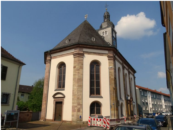
Ost-Front der Karlskirche in Zweibrücken (Matthias Dreyer, 2018)
