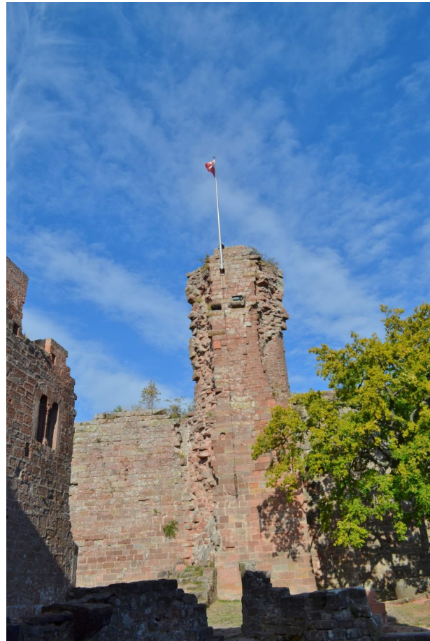
Blick auf den heute noch 20 Meter hohen ehemaligen Wehrturm. Er ist Teil der elf Meter hohen Schildmauer. (Dr. Hans-Günther Clev, 2018)
