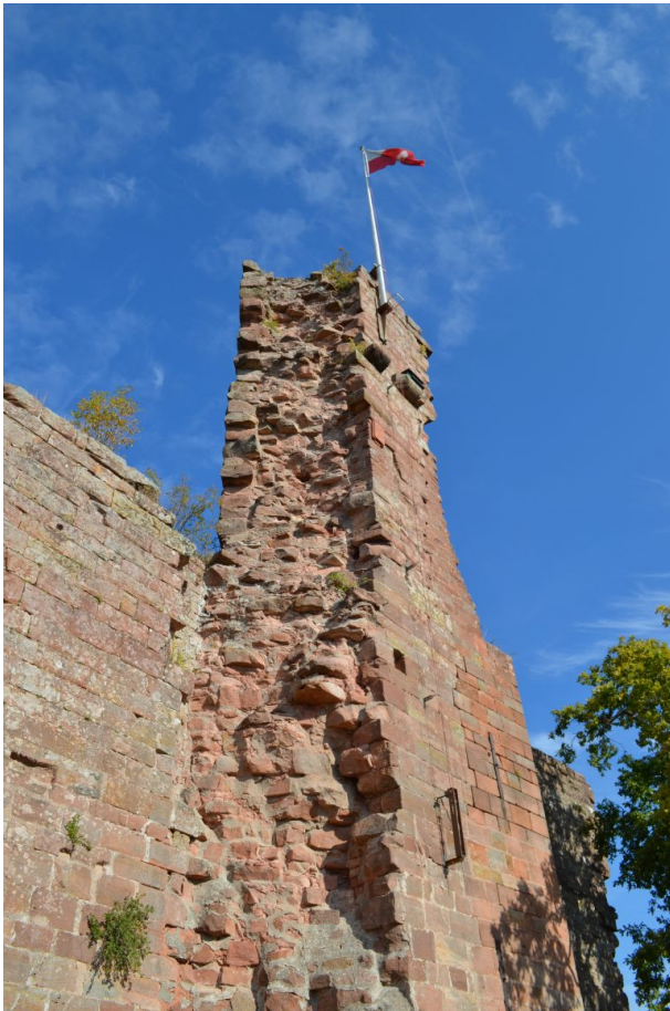
Der heute noch 20 Meter hohe Bergfried ist Teil der elf Meter hohen Schildmauer. (Dr. Hans-Günther Clev, 2018)
