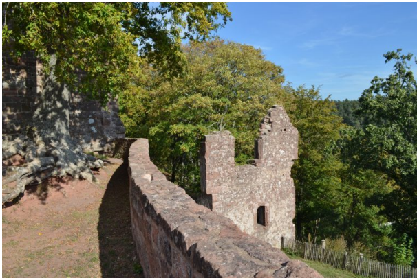
Blick von der Oberburg auf die Überreste eines ehemaligen Zugangs mit Torbogen im Osten der Anlage. (Dr. Hans-Günther Clev, 2018)
