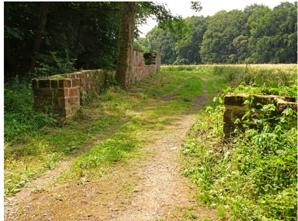
Teil der Mauer, die den Wildrosengarten in Zweibrücken begrenzt. (Matthias Dreyer, 2018)
