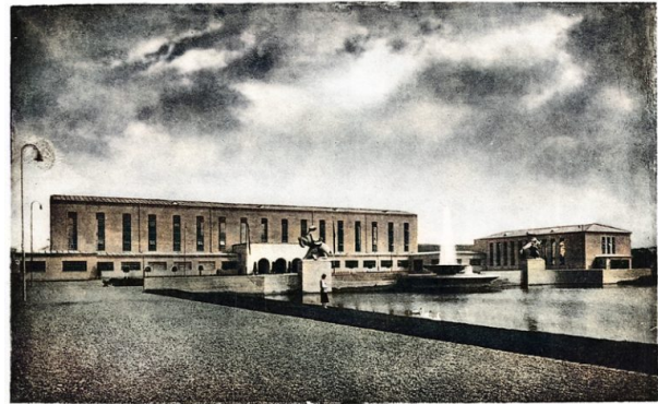
Blick auf den Vorhof der früheren Ausstellungshallen
