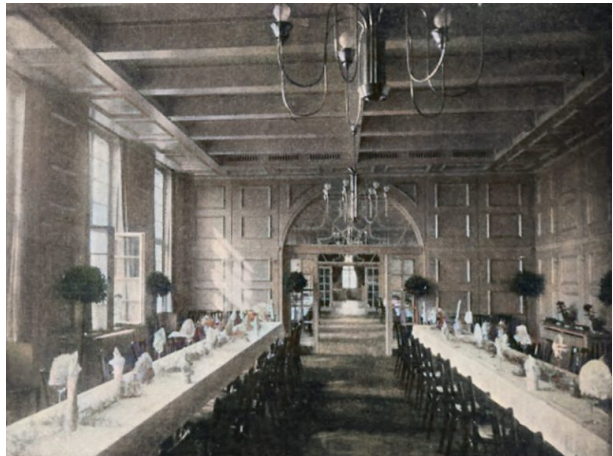
Speisegaststätte auf dem ehemaligen Ausstellungsgelände
