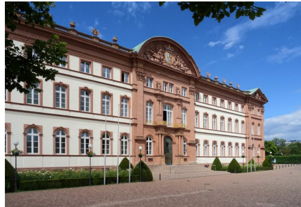
Blick auf die nach Süden ausgerichtete Hoffassade des Zweibrücker Schlosses. Zu sehen sind die vertikale und horizontale Fassadengliederung, die große Freitreppe, der dekorierte Segmentgiebel, sowie die Balustarde vor dem flachen Dach. (Christian Weidler, 2015)
