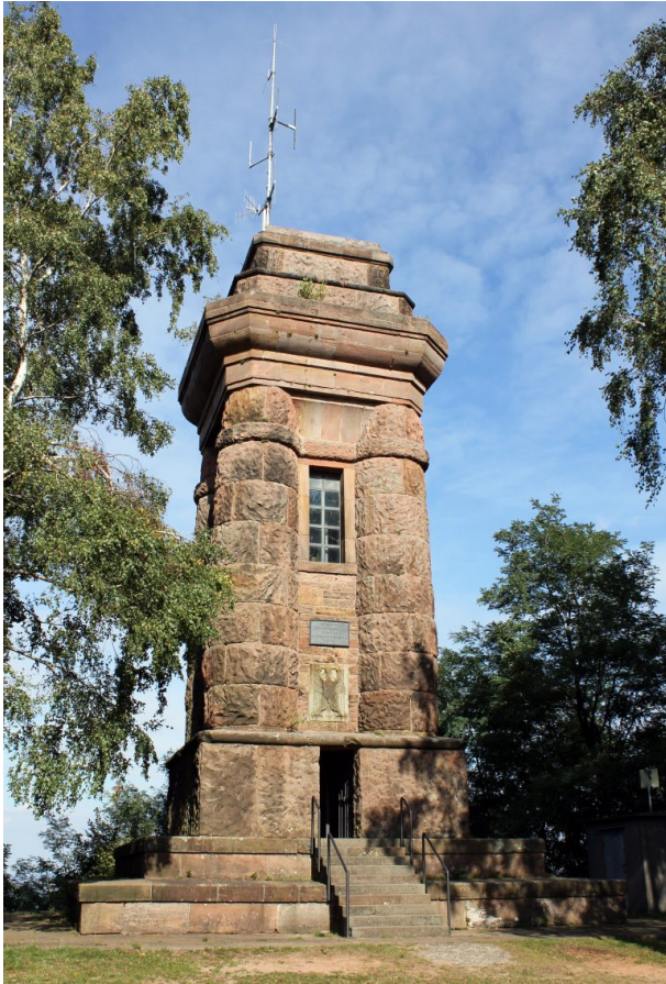
Blick auf den Eingangsbereich des Bismarckturms in Landstuhl ( Werner Lademann, 2010)
