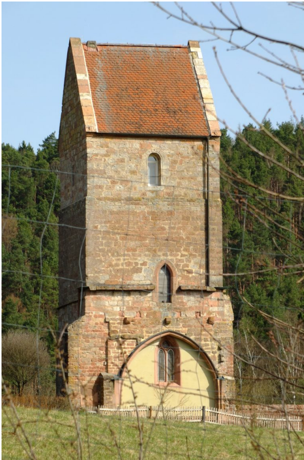
Turm von Süden, Dach mit Ortgangplatten. (A. Fröhlich, 2018)
