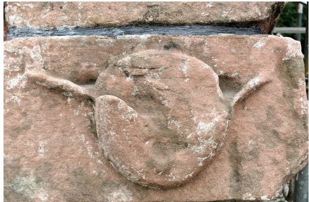
Eingemeißelter Tierkopf zur Geisterabwehr am südlichen Dach. (A. Fröhlich)
