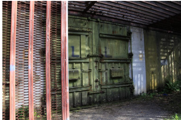
Verschlossenes Tor auf dem Gelände des ehemaligen US-Sonderwaffenlagers Area One in Fischbach bei Dahn. (Bernd Wagner, 2018)
