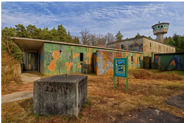
Leerstehende Gebäude des ehemaligen US-Sonderwaffenlagers der Area One in Fischbach bei Dahn. Rechts im Bild steht der ehemalige Überwachungsturm. Im Vordergrund ist eine der heute auf dem Gelände aufgestellten Informationstafeln zu sehen. (Bernd Wagner, 2018)
