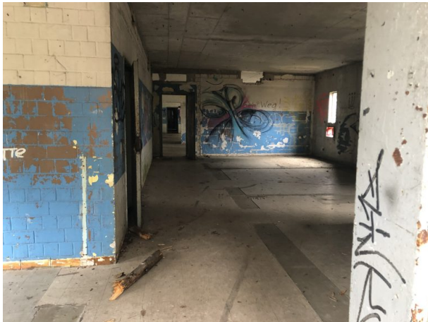
Innenraum eines Wachgebäudes (Dana Taylor, 2021)
