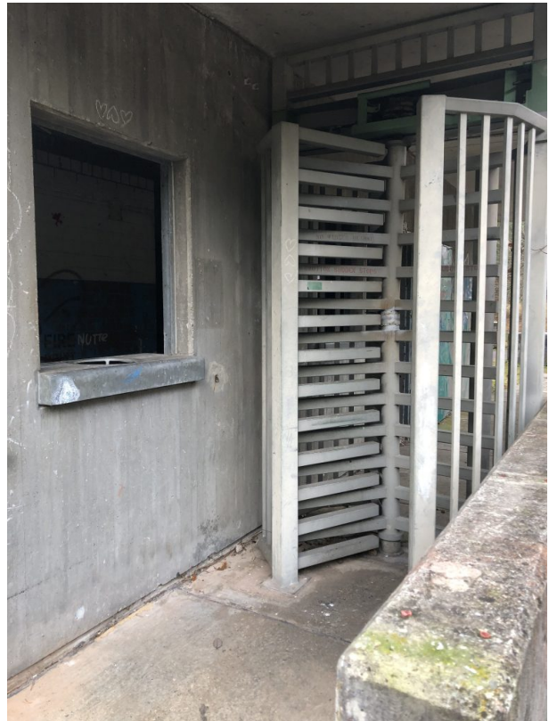
Ehemaliger Zugang zu einem Wachgebäude (Dana Taylor, 2021)
