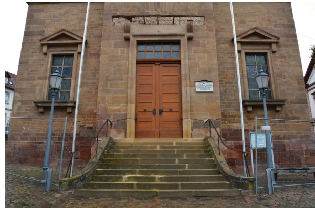
Ostportal der evangelischen Stadtkirche in Kusel mit einer breiten Treppe (Sonja Kasprick, 2019)
