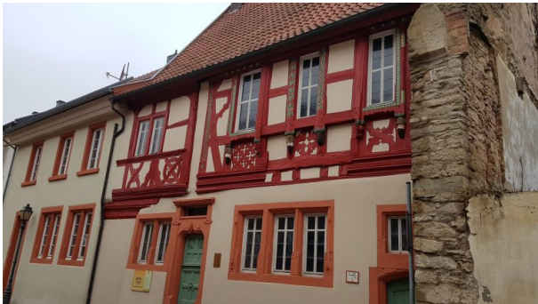
Schuck'sches Haus Gesamtansicht (Arno Mohr, 2018)
