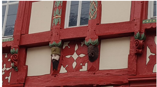
Holzgeschnitzte Fratzen an Außenfassade (Arno Mohr, 2018)
