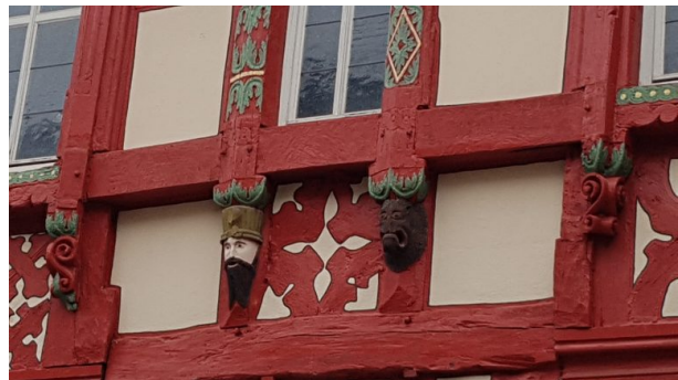
Holzgeschnitzte Fratzen an Außenfassade (Arno Mohr, 2018)
