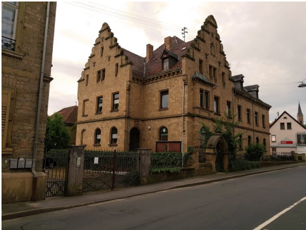
Sandsteingebäude des ehemaligen Amtsgerichts in Obermoschel (Arno Mohr, 2018)
