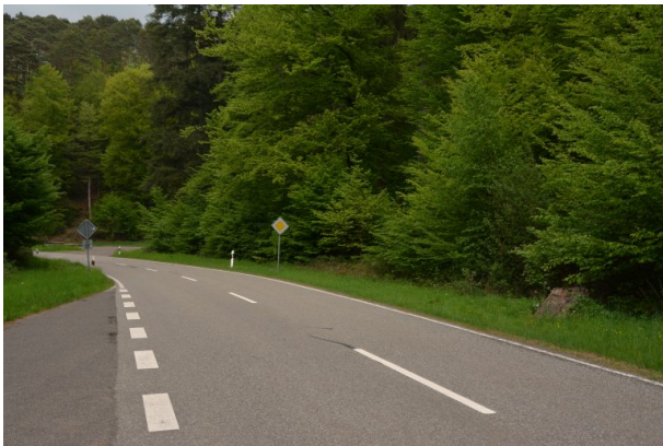
L504 aus Richtung Waldleiningen. Der Ritterstein befindet sich hier am rechten Straßenrand (Sonja Kasprick, 2019)
