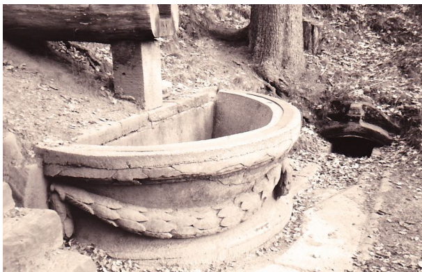
Die Hälfte der Brunnenschale aus dem Garten des Trippstadter Schlosses als Fassung für den Wasserablauf des Burgalbweiher. Das Wasser fließt über eine Zuleitung aus Holz in das Auffangbecken. (Erhard Rohe, 1993)
